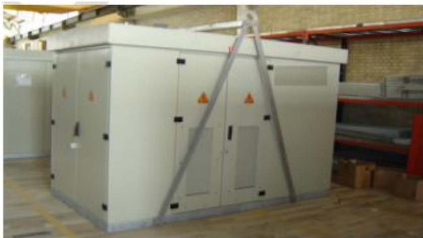
شکل شماره ۵: استفاده از قالب فلزی جهت جابجایی پست پیش ساخته کمپکت
