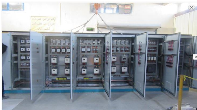
شکل شماره ۳-طریقه حمل با استفاده از زنجیر
